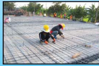
6. วางตะแกรงเหล็ก
