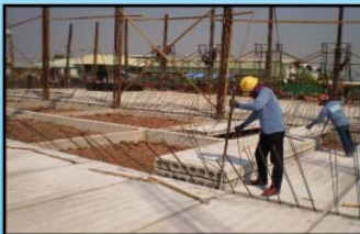
4. ยกแผ่นพื้นวางบนหลังคาน
