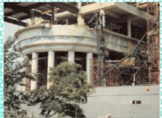
ภาพที่ 1 สีเขียวบนผิวคอนกรีตปรากฏขึ้น หลังจากแกะแบบคอนกรีตออก (อาคารใน Washington, DC. ภาพจาก Slag Cement Association)
