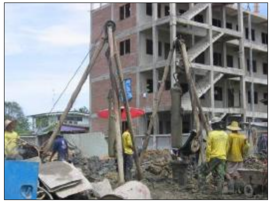
รูปที่ 5 การขุดเจาะเข็มเจาะเล็กซึ่งพบเห็นได้ทั่วไปใน จ.สมุทรปราการ
