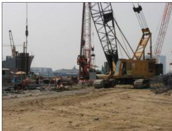
รูปที่ 4 การขุดเจาะเข็มเจาะใหญ่ของโครงการขนาดใหญ่ ใน จ.สมุทรปราการ
