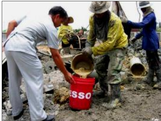
รูปที่ 15 การเก็บตัวอย่างน้ำจากกันหลุมเข็มเจาะเพื่อทดสอบหาคลอไรด์และซัลเฟต
