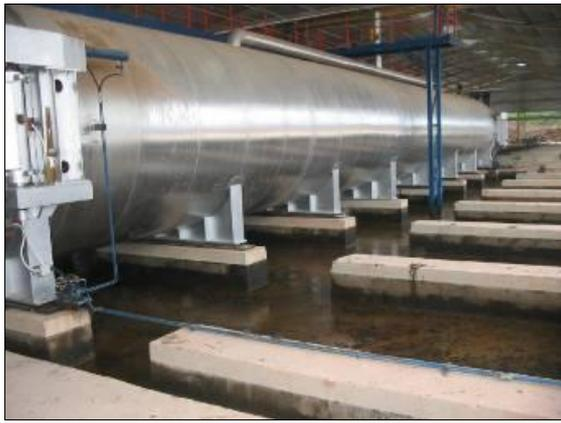
ภาพที่ 3 การทำลายคอนกรีตของกรดที่บริเวณบ่อน้ำเสียปาล์มสด
