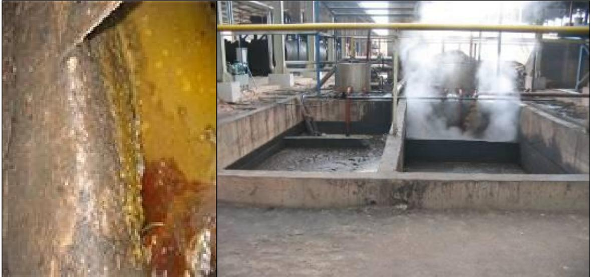
ภาพที่ 2 ความเสียหายของคอนกรีตที่เกิดจากกรดกัดกร่อนที่บริเวณบ่อน้ำเสียโรงงานปาล์ม
