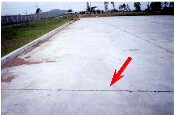
รูปที่ 11 รอยแตกกว้างในแนวยาว (Longitudinal crack)
