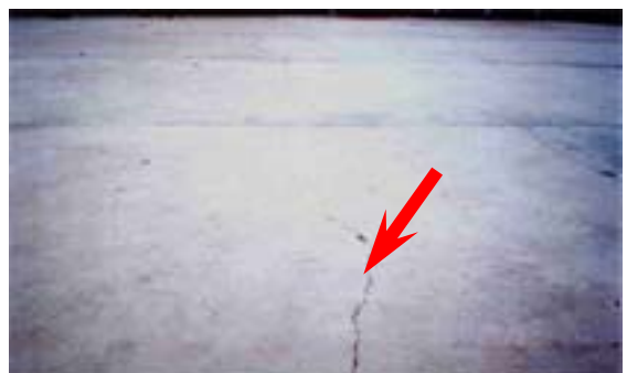
รูปที่ 5 รอยแตกร้าวในแนวขวาง (Transverse crack)
