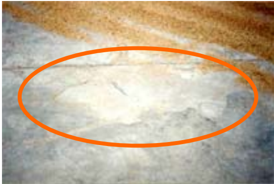
รูปที่ 3 การแตกกะเทาะ (Spalling)
