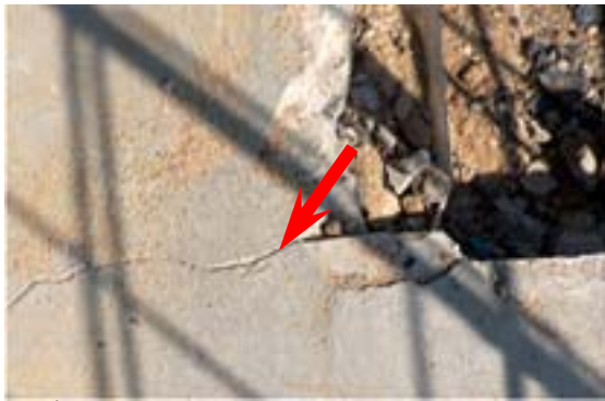
รูปที่ 7 รอยแตกกว้างในแนวขวาง (Transverse crack)
