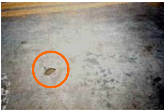
รูปที่ 4 การแตกกะเทาะ (Spalling)
