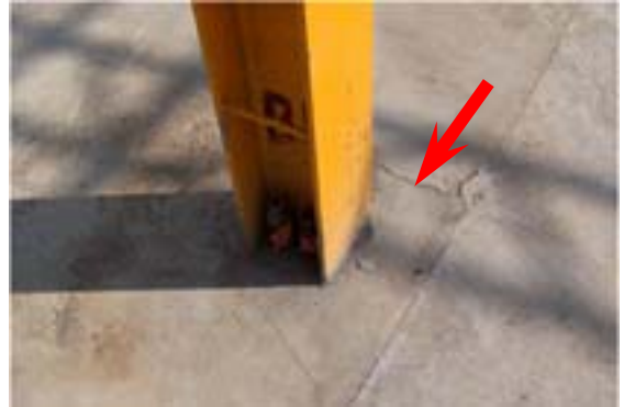
รูปที่ 12 รอยแตกกว้างเนื่องจากทรุดตัวไม่เท่ากัน (Differentiate settlement crack)
