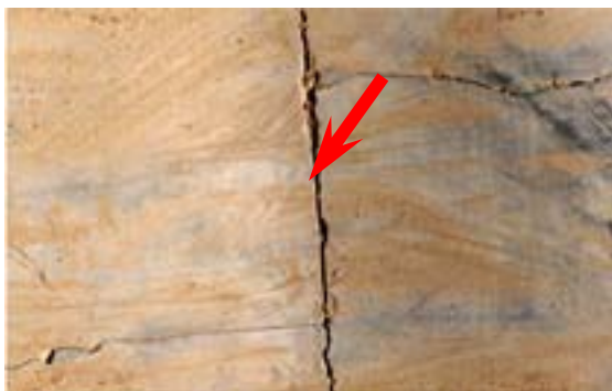
รูปที่ 9 รอยแตกกว้างในแนวขวาง (Transverse crack)
