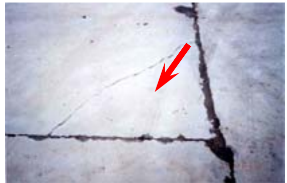
รูปที่ 10 รอยแตกกว้างตามมุม (Corner crack)
