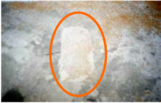
รูปที่ 2 การแตกกะเทาะ (Spalling)
