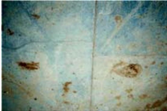
รูปที่ 8 รอยแตกกว้างในแนวขวาง (Transverse crack)
