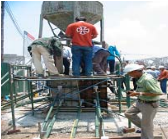
รูปที่ 8 แสดงการทดลองเทคอนกรีตในทดลองขนาด 1 ลูกบาศก์เมตร (Big Cube) ที่จัดเตรียมไว้หน้างาน เพื่อตรวจสอบระยะเวลาการตกและอุณหภูมิคอนกรีต
