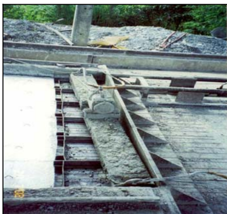
รูปที่ 3 แสดงเครื่องจักรของโรงหล่อ หากใช้คอนกรีตที่ค่ายุบตัวสูงจะทำให้เกิดการเอียงอย่างมาก
