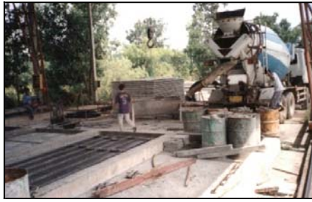
รูปที่ 13 แสดงการจัดส่งคอนกรีต ในโรงหล่อขนาดเล็ก
