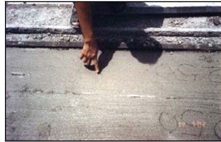
รูปที่ 14 แสดงการแตกร้าวเนื่องจาก การหดตัวแบบพลาสติก ของคอนกรีต แก้ไขโดยแนะนำเวลาที่เหมาะสมในการบ่มคอนกรีต
