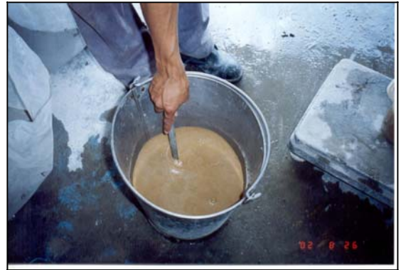
รูปที่4 แสดงวิธีการผสมแบบที่1 โดยการผสมฝุ่น ทรายร่วมกับน้ำก่อนเติมลงในเครื่องผสม
