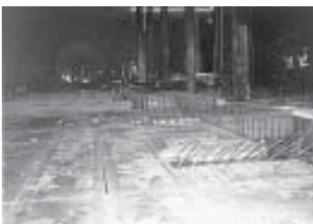
รูปที่ 14-10 การบ่มแบบควบคุมอุณหภูมิ โดยการใช้น้ำเย็นเป็นฉนวนป้องกันการสูญเสียความร้อนบริเวณผิวหน้าคอนกรีตฐานรากแผ่นขนาดใหญ่
