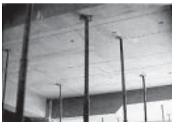
รูปที่ 14-12 ภายหลังจากคอนกรีตมีอายุครบกำหนด หรือมีกำลังอัดตามที่ออกแบบไว้แล้ว ควรถอดแบบหล่อพร้อมค้ำยันออก หากจำเป็นต้องเหลือค้ำยันไว้บ้างก็ต้องกระจายให้ทั่ว 4
