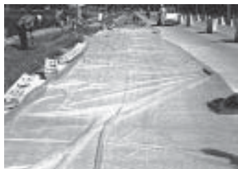
ก) การใช้สารทลวบ่มคอนกรีตหรือน้ำยา ข) การใช้แผ่นพลาสติกคลุมบ่มคอนกรีต
