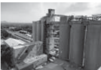
รูปที่ 2-24 ไซโลเก็บปูนซีเมนต์ (Cement Silo)
