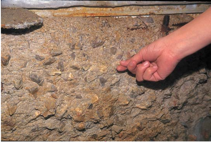
ความเสียหายของคอนกรีตในห้องแช่แข็งที่เกิดจากกระบวนการ Freezing & Thawing
