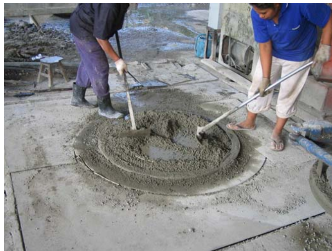
รูปแสดงลักษณะของการเทคอนกรีตลงบนแบบหล่อ
