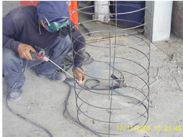
รูปแสดง ลักษณะการเชื่อมเหล็กตะแกรงโดยใช้ไฟฟ้า
