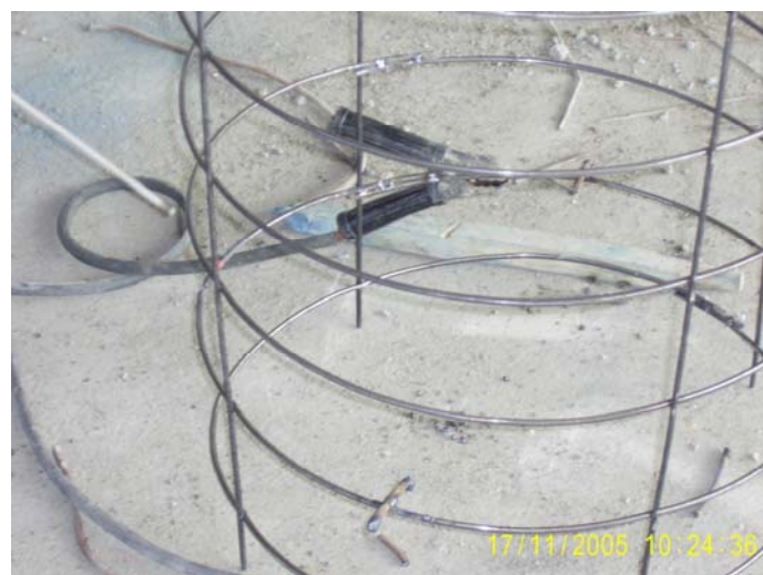
รูปแสดง ลักษณะของ stud ที่ทำการเชื่อมติดกับเหล็กตะแกรง
