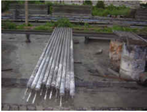
รูปแสดงตัวอย่างของแบบหล่อเสาเข็ม
