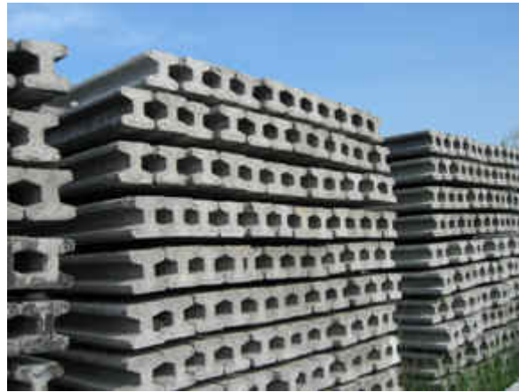
รูปแสดงรายละเอียดการกองเก็บ Stock เสาค้ำด้านหน้างาน
