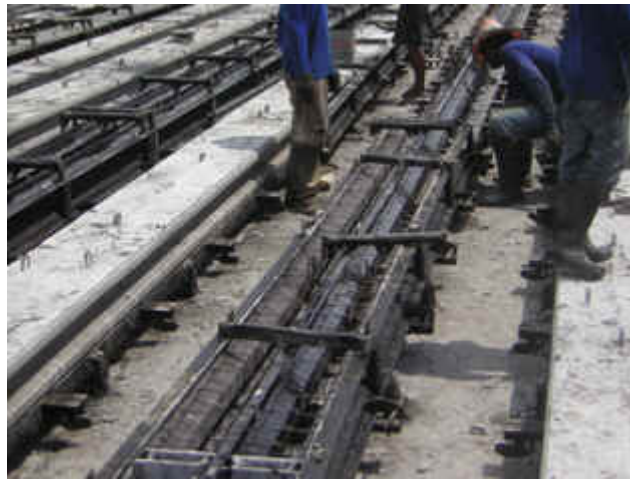
รูปแสดงรายละเอียดการเสริมลวดอัดแรง และการเสริมเหล็กปลอก
