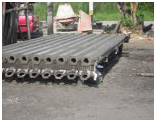
ตัวอย่างการเตรียมเคลื่อนย้ายสินค้าภายหลังจากคอนกรีต Set ตัวแล้ว
