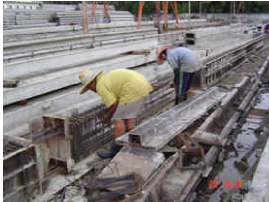
รูปแสดงรายละเอียดการวางเหล็กปลอก
