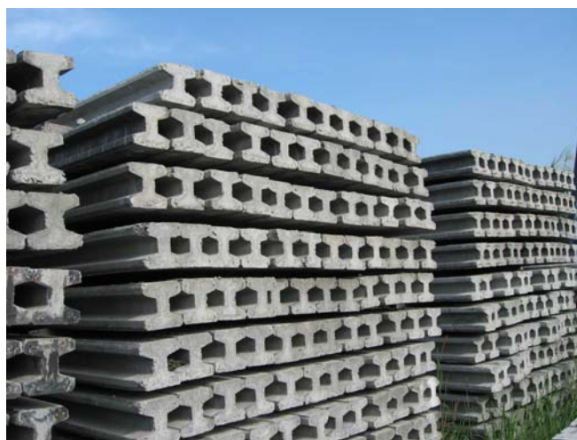
รูปแสดงลักษณะการกองเก็บเสาเข็ม
