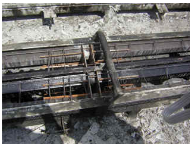
รูปแสดงรายละเอียดการเสริมลวดอัดแรง และการเสริมเหล็กปลอก
