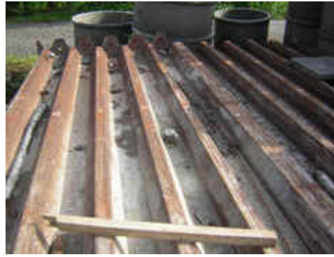
รูปแสดงตัวอย่างของแบบหล่อเสาเข็ม
