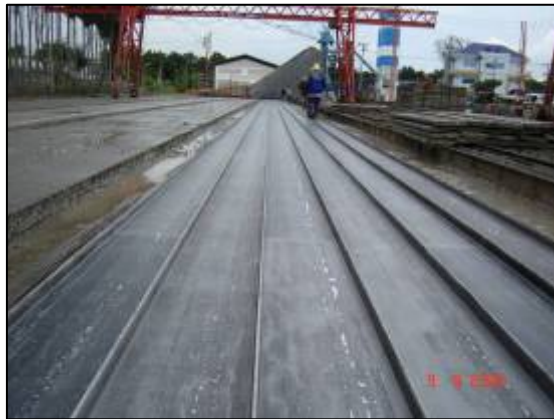
รูปแสดงแท่นผลิตแผ่นพื้นคอนกรีตสำเร็จรูปชนิดตัน
