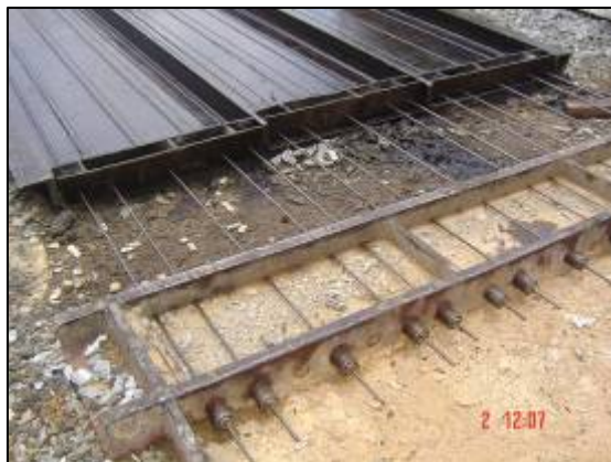
รูปแสดงแผงยึดลวดแผ่นพื้นคอนกรีตสำเร็จรูปอัดแรงแบบตัน
