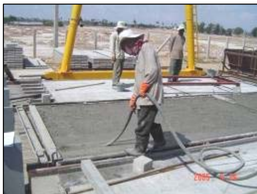
3. ใช้เครื่องจี้เขย่าด้วย Poker Vibrator
