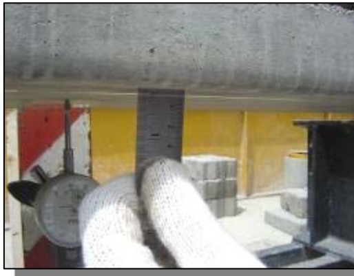
รูปแสดงการวัดความโค้งของชั้นคอนกรีต
