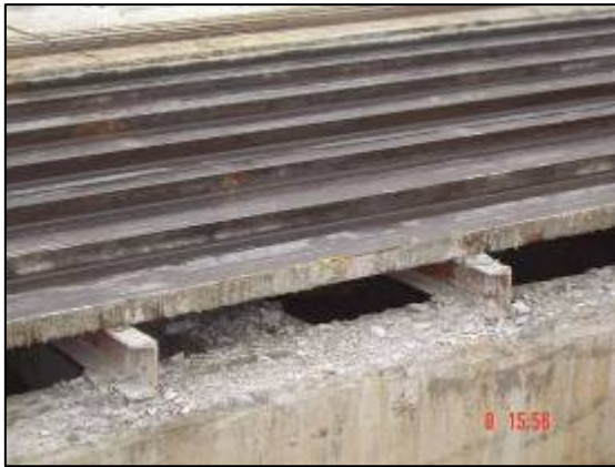
รูปแสดงแท่นผลิตแผ่นพื้นคอนกรีตสำเร็จรูปชนิดตัน
