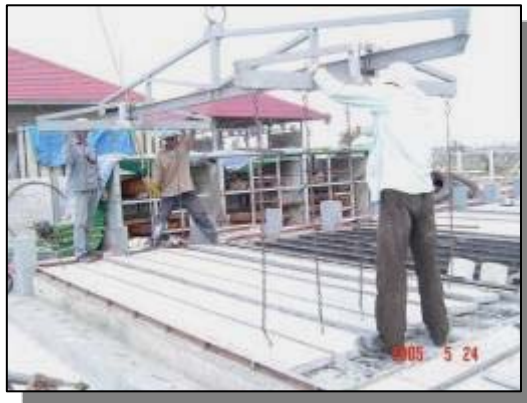
3. ทำการยกย้ายสินค้าด้วยอุปกรณ์เฉพาะ
