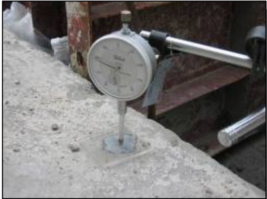
รูปแสดงการติดตั้ง Dial Gauge ที่ริมแผ่น ด้านหัว
