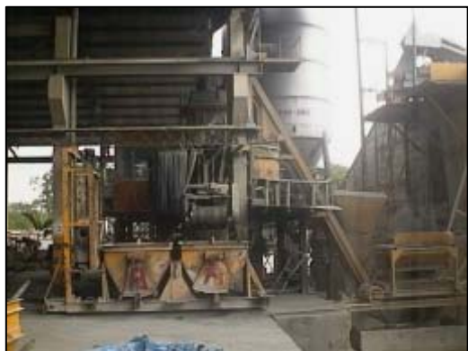
5. ปลปล่อยคอนกรีตที่ผสมแล้วลงสู่รถลำเลียง
