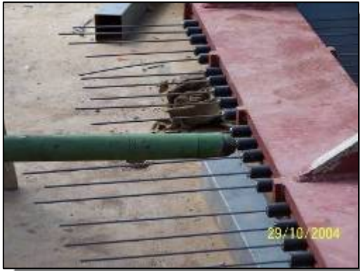
3. ทำการตั้งลวดตามแรงดึงที่กำหนด
