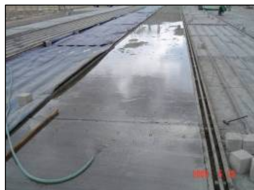
6. ทำการบ่มด้วยการฉีดน้ำ
