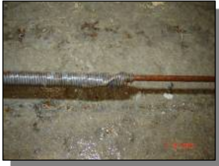
รูปแสดงอุปกรณ์การต่อลวดเหล็กแรงดึงสูง
