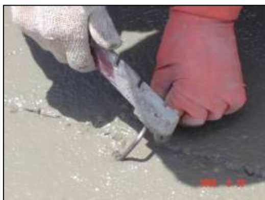
5. ทำการฝัง Shear Steel
