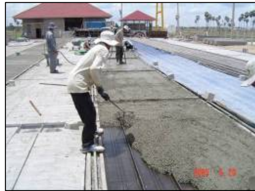
2. ทำการเกลี่ยคอนกรีตให้กระจายอย่างทั่วถึง
