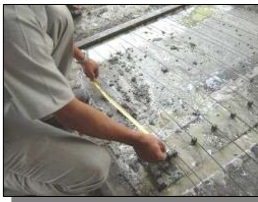
5. ตรวจสอบและบันทึกค่าแรงดึงและระยะยึด
