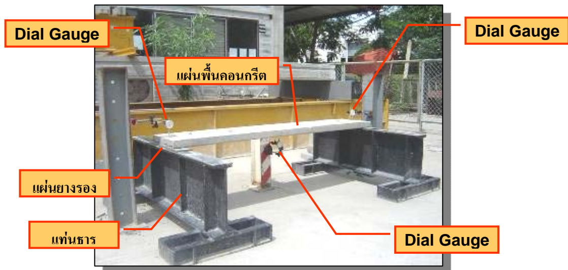
รูปแสดงการจัดเตรียมการทดสอบการรับน้ำหนักบรรทุกของแผ่นพื้นคอนกรีตสำเร็จรูปอัดแรง
