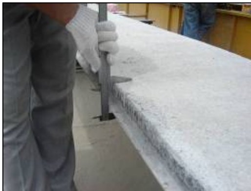
รูปแสดงการวัดความหนาของชิ้นส่วน คอนกรีต ภาคตัดขวางกลวง
