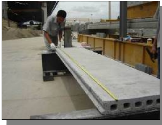
รูปแสดงการวัดความยาวของชิ้นส่วนคอนกรีต ภาคตัดขวางกลวง
