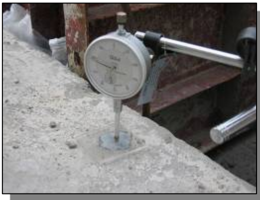
รูปแสดงการติดตั้ง Dial Gauge ที่ริมแผ่น ด้านหัว
