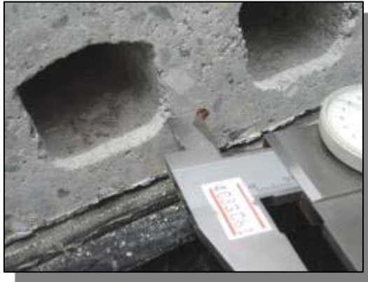
รูปแสดงการวัดความหนาของคอนกรีตหุ้ม
