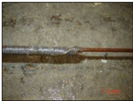
รูปแสดงอุปกรณ์การต่อลวดเหล็กแรงดึงสูง
