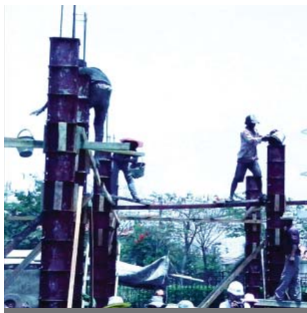
รูปที่ 3 การเทคอนกรีตเสาสูงโดยในแรงงานคน
