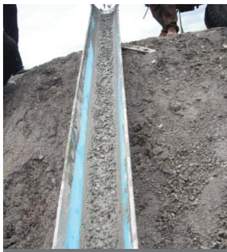
รูปที่ 6 Flowing concrete ในคอนกรีตพ่นรางยาว 4 เมตร โดยไม่มีการเติมน้ำ
