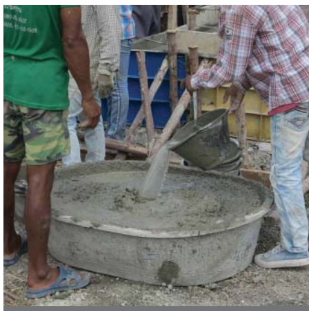
รูปที่ 2 การเติมน้ำเพิ่มความเหลวระหว่างการเทคอนกรีต
