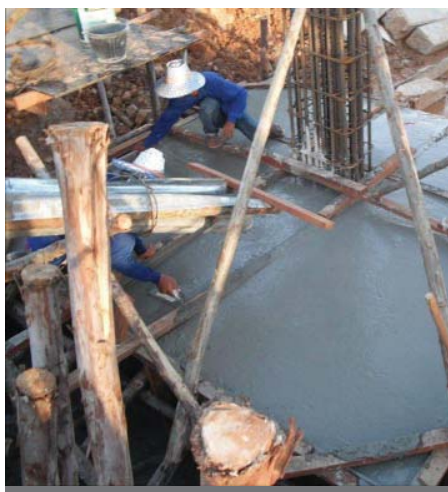
รูปที่ 5 Flowing concrete ในฐานราก Free Fall สูง 2.5 เมตร โดยไม่เกิดการแยกตัวของคอนกรีต
