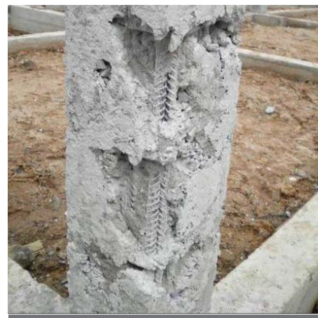
รูปที่ 4 คอนกรีตธรรมดาเติมน้ำจนเหลวแล้วเทเสาสูง 3 เมตร พบว่ามีการแยกอย่างตัวรุนแรง
