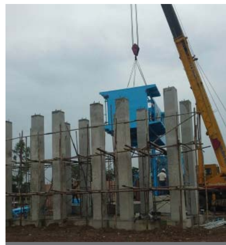
รูปที่ 7 Flowing concrete ในเสา Free Fall สูง 6 เมตร โดยไม่เกิดการแยกตัวของคอนกรีต
