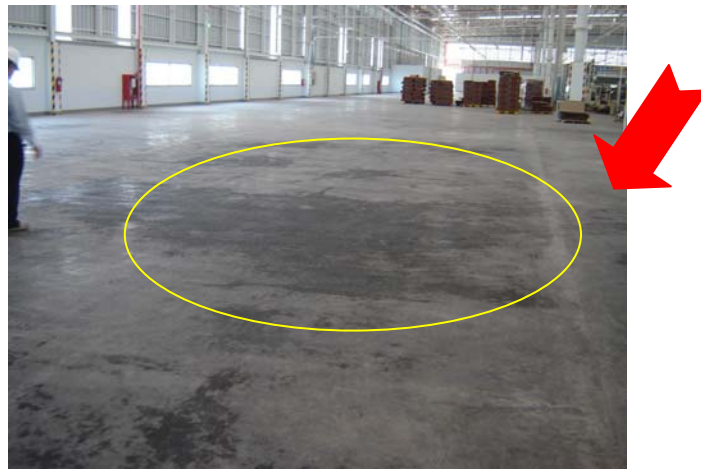
รูปที่ 3 – ความชื้นปรากฏเป็นหย่อมบนพื้นคอนกรีต แต่รอยต่อที่เป็นแนวยาวทางขวาแห้ง
