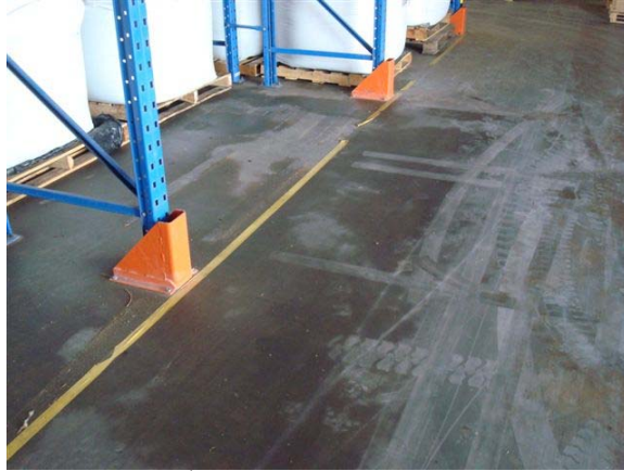
รูปที่ 2 – การวางสินค้าใกล้กับพื้นทำให้การหมุนเวียนของอากาศบริเวณผิวคอนกรีตลดลง
