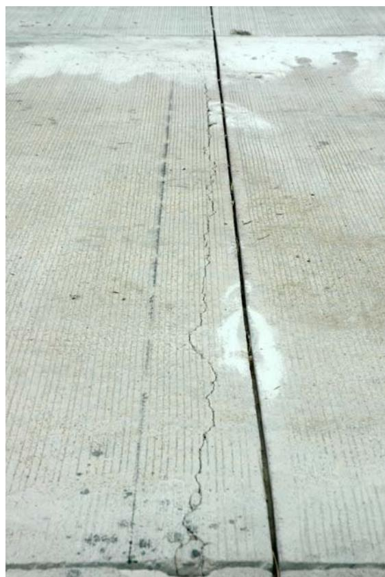
**การหดตัวด้วยการใช้เลื่อยตัด (Sawed cut) หากหดตัวเกินไป รอยแตกจะเกิดแบบกระจายทั่วไป**
