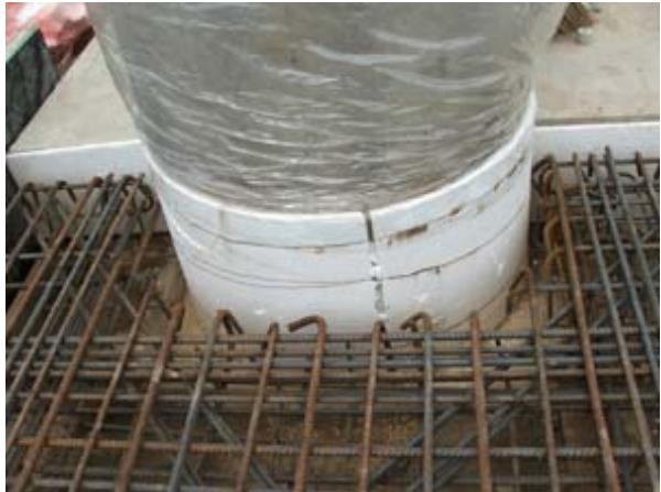
เป็นรอยต่อที่ทำขึ้นเพื่อให้โครงสร้างคอนกรีตส่วนแนวเดิง เช่น เสา ผนัง สามารถเลื่อนตัวอย่างอิสระจากโครงสร้างคอนกรีต ในแนวราบ เช่น พื้น เพื่อไม่ให้เกิดการยึดรั้งอันเป็นสาเหตุให้เกิดการแตกกราฟของโครงสร้างในระยะยาว ส่วนวัสดุที่ใช้ทำรอยต่อมักใช้วัสดุที่ไม่เปื่อยยุ่ง่าย ที่นิยมใช้กันมักจะเป็นโพเมหรือแผ่นยาง โดยจะหุ้มหรือกันด้วยวัสดุเหล่านี้ก่อนจะเทคอนกรีต
