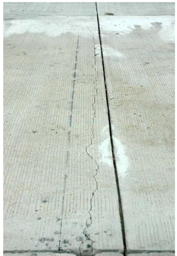
**การทำรอยต่อด้วยการใช้เลื่อยตัด (Sawed cut) หากรอยตัดตื้นเกินไป รอยแตกจะเกิดแบบกระจายทั่วไป**
