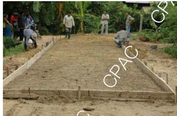
ทำผิวของแบบให้เปียกหรือทาด้วยน้ำมันเลี้ยกว่อน เพื่อป้องกันการเกาะแบบ ควรทาหน้ามันนก่อนการวางเหล็กเสริม เพราะถ้าหน้ามันถูกกับเหล็กเสริมจะเป็นการทำลายแรงยึดเหนี่ยวระหว่างคอนกรีตกับเหล็กเสริม วิธีที่ดีเพื่อรักษาแบบไม่ให้แน่นและป้องกันการบิดองคืบให้แบบนั่นซึ่งมันน้ำอยู่ตลอดเวลา ก่อนที่จะเทคอนกรีต ไม่ทิ้งสัดเกินไปอาจจะหาดตัวได้แต่ถ้าไม่นั้นแห้งเกินไปอาจเกิดการอหวีดและการอหวีดเมื่อเปียก
