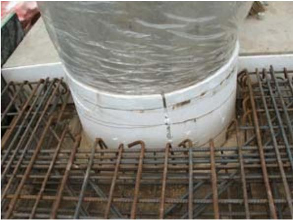
เป็นรอยต่อที่สร้างขึ้นเพื่อให้โครงสร้างคอนกรีตส่วนแนวตั้ง เช่น เสา ผนัง สามารถเลื่อนตัวอย่างอิสระจากโครงสร้างคอนกรีตในแนวราบ เช่น พื้น เพื่อไม่ให้เกิดการยึดรั้งอันเป็นสาเหตุให้เกิดการแตกร้าวของโครงสร้างในระยะยาว ส่วนวัสดุที่ใช้ทำรอยต่อมักใช้วัสดุที่ไม่เปื่อยยุ่ยง่าย ที่นิยมใช้กันมักจะเป็นโฟมหรือแผ่นยาง โดยจะหุ้มหรือกั้นด้วยวัสดุเหล่านี้ก่อนจะเทคอนกรีต
