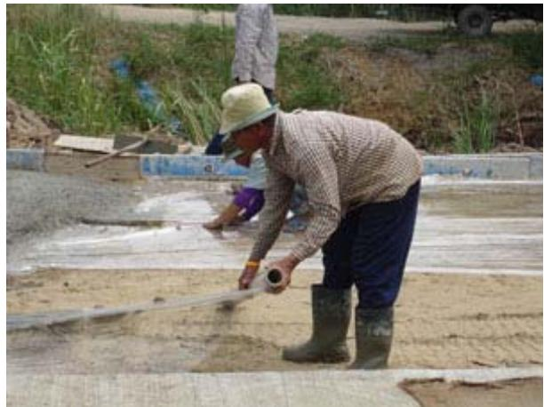
สำหรับโครงสร้างที่ต้องการป้องกันความชื้นจากดินขึ้นสู่พื้น โดยมากต้องทำการปูพลาสติกกันชื้น การปูพลาสติกควรซ้อนกันอย่างน้อย 0.30 เมตร และมีการเชื่อมพลาสติกเพื่อทابต่อกันให้สนิท โดยควรปูภายหลังการผูกเหล็กและก่อนเทคอนกรีต การปูจะต้องยกเหล็กให้ลอยขึ้นแล้วจึงกลั้งม้วนไปเต็มผ้าปูพลาสติกกันชื้นก่อน แล้วลงไปผูกเหล็กอาจทำให้พลาสติกฉีกขาดได้ ส่วนความหนาและชนิดของพลาสติกกันชื้นให้เป็นไปตามมาตรฐานที่วิศวาระแนะนำ
