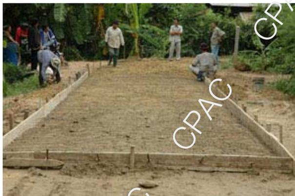
ทำผิวของแบบให้เปียกหรือทาด้วยน้ำมันเสียก่อน เพื่อป้องกันการเกาะแบบ ควรทาน้ำมันก่อนการวางเหล็กเสริมเพราะถ้าน้ำมันถูกกับเหล็กเสริมจะเป็นการทำลายแรงยึดเหนี่ยวระหว่างคอนกรีตกับเหล็กเสริม วิธีที่ดีเพื่อรักษาแบบไม้ให้แน่นและป้องกันการบิดงอคือ ให้แบบนั้นชุ่มน้ำอยู่ตลอดเวลาก่อนที่จะเทคอนกรีต ไม้ที่ยังสดเกินไปอาจจะหดตัวได้แต่ถ้าไม้แห้งเกินไปอาจจะเกิดการงอหรือบิดเมื่อเปียก
