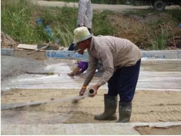
สำหรับโครงสร้างที่ต้องการป้องกันความชื้นจากดินขึ้นสู่พื้น โดยมากต้องทำการปูพลาสติกกันชื้น การปูพลาสติกควรซ้อนกันอย่างน้อย 0.30 เมตร และมีกาวยเชื่อมพลาสติกเพื่อทาบทอกันให้สนิท โดยควรปูภายหลังการผูกเหล็กและก่อนเทคอนกรีต การปูจะต้องยกเหล็กให้ลอยขึ้นแล้วจึงทิ้งม้วนไปแต่ถ้าปูพลาสติกกันชื้นก่อน แล้วลงไปผูกเหล็กอาจทำให้พลาสติกฉีกขาดได้ ส่วนความหนาและชนิดของพลาสติกกันชื้นให้เป็นไปตามมาตรฐานที่วิศวกรแนะนำ
