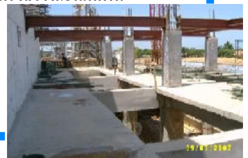
รูปที่ 2 - โครงสร้างหลังการเท
