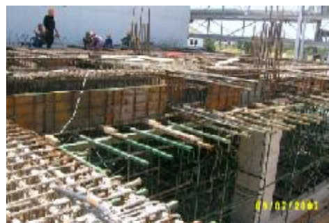
รูปที่ 1 - โครงสร้างก่อนเทคาน
