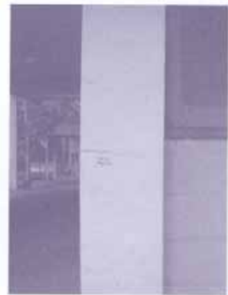
รูปที่ 13 รอยแตกที่เสาเป็นปล้องๆ เช่นนี้ เกิดจากฐานรากตัวอื่นทรุดตัวแล้วดึงรั้งจนเสาด้านนี้โก่งงอ ปลายของรอยร้าวชี้ไปยังบริเวณตำแหน่งฐานรากที่ทรุดตัว
