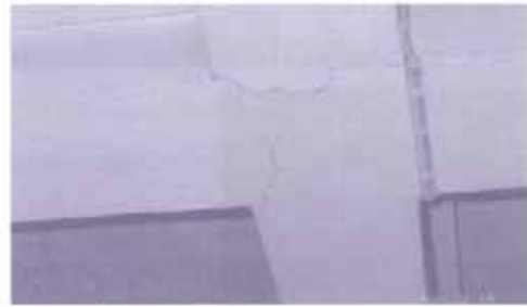
รูปที่ 6 คานรับน้ำหนักไม่ไหวเกิดการแอ่นตัว รอยแตกเป็นรูปตัวยู รอยแตกจะเริ่มจากใต้ท้องคานและแตกลามออกทั้งสองข้างของคาน
