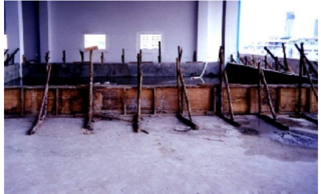
แสดงการวางน้ำหนักบรรทุกด้วยการขังน้ำ
