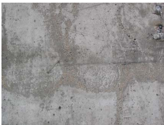
รูปที่ 3 ตัวอย่างคอนกรีตเป็นริ้วทราย
