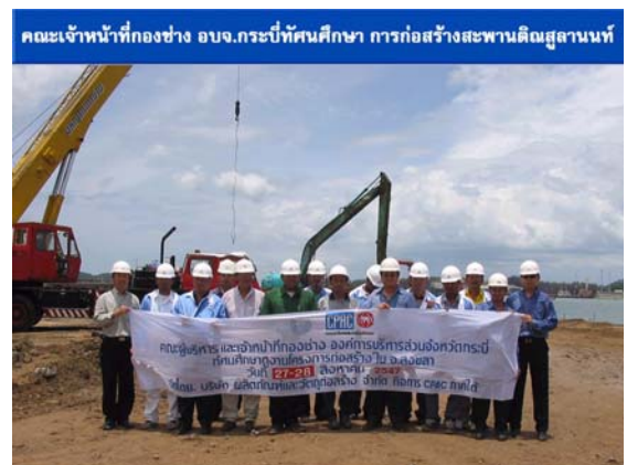
รูปที่ 4 คณะ อบจ.จังหวัดกระบี่เยี่ยมชมการก่อสร้างสะพานติณสูลานนท์
