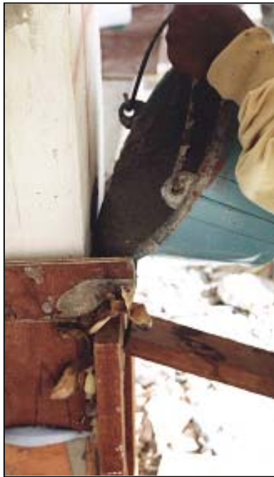
รูปที่ 14 การเทคอนกรีตใหม่เข้าเสริมโครงสร้าง
