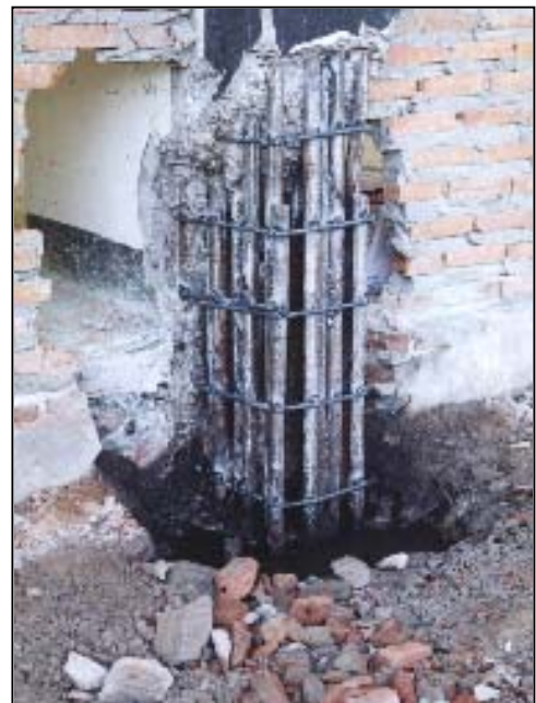
รูปที่ 12 การขัดสนิมและการเสริมหน้าตัดเหล็กเสริมในโครงสร้าง
