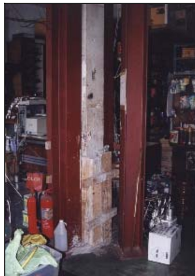
รูปที่ 19 การเสริมความแข็งแรงของเสาเนื่องจากโครงสร้างเกิดการแตกร้าวจากคลอไรด์
