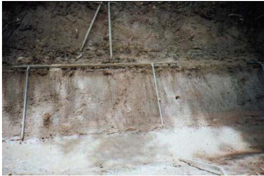
ตั้งแบบ Slope ประมาณ 40 องศา หน้า 5 ซม.
