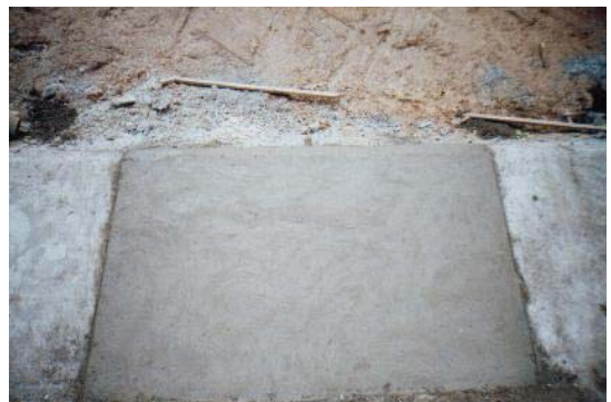
คอนกรีตที่เทเสร็จแล้วใช้เวลาประมาณ 30 นาที/แผง (2x1.5 ม.)
