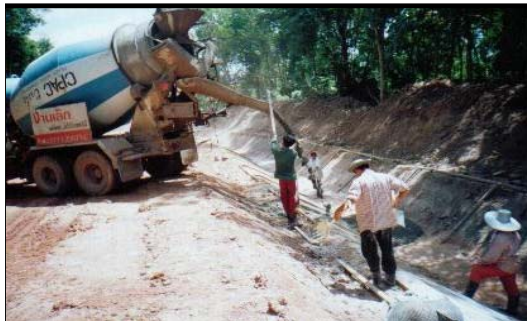
เริ่มเทคอนกรีตส่วนท้องก่อน
