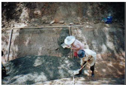
ตักคอนกรีตให้ติดตาม Slope
