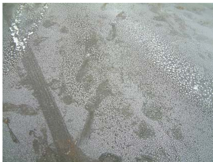
รูปที่ 11 พื้นที่ขัดแต่งผิวหน้าเสร็จต้องทำการบ่มทันที ในภาพบ่มด้วย Curing Compound
