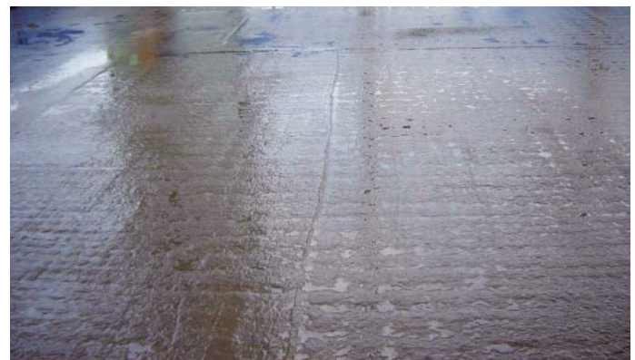
รูปที่ 2 ปริมาณเยิ้ม (Bleeding) ที่เหมาะสม ไม่มากและไม่น้อยเกินไป
